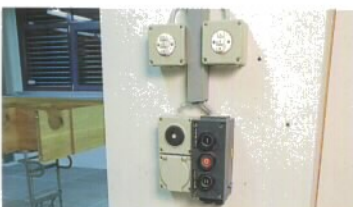
Sicheres Schalten in Griffweite: Das Ex-Tastenelement.
